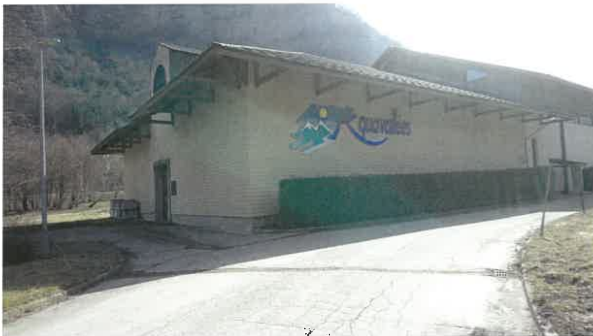
Site de la station d'épuration Aquavallées avec au fond les berges de la Romanche
