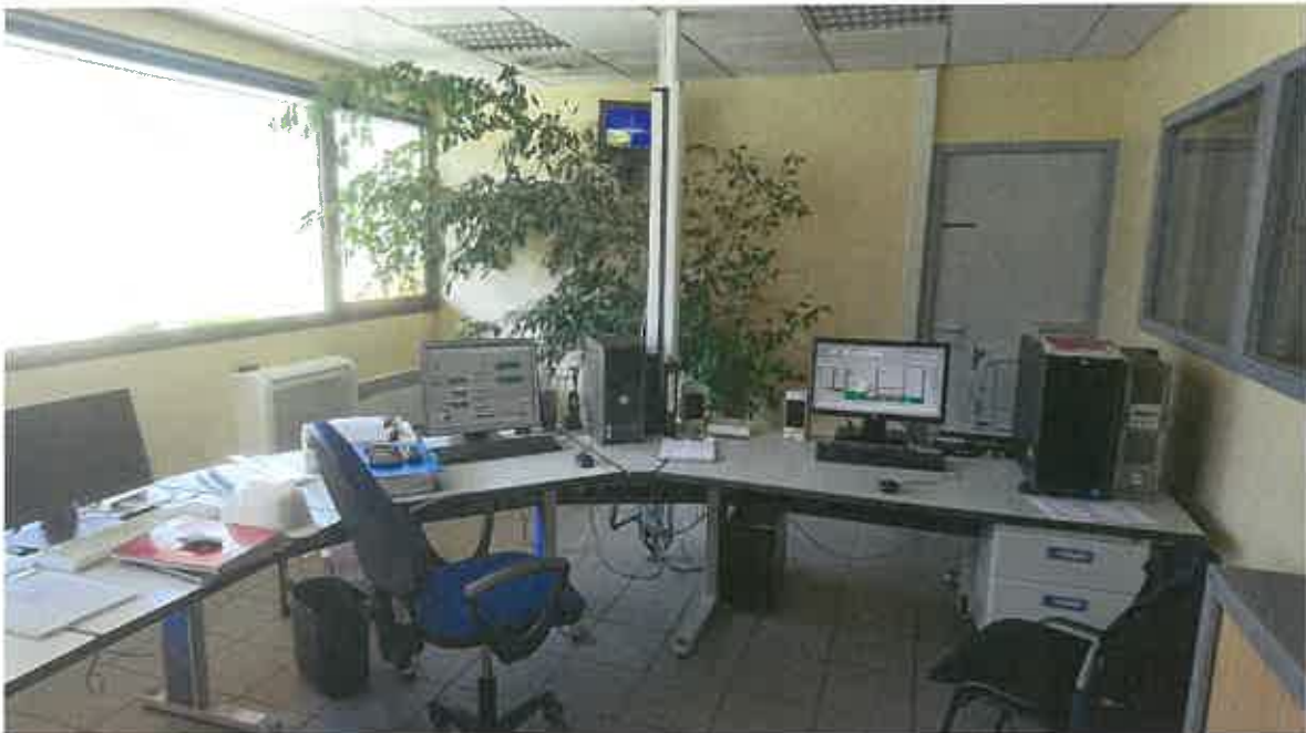
Site de la station d'épuration Aquavallées : poste de contrôle réseau et station
